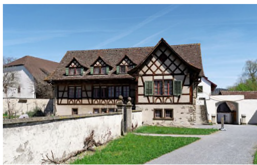
Laut dem Kloster Fahr lässt sich das Riegelhaus weder aussen noch innen richtig dämmen, was energetisch nicht vertretbar sei.
