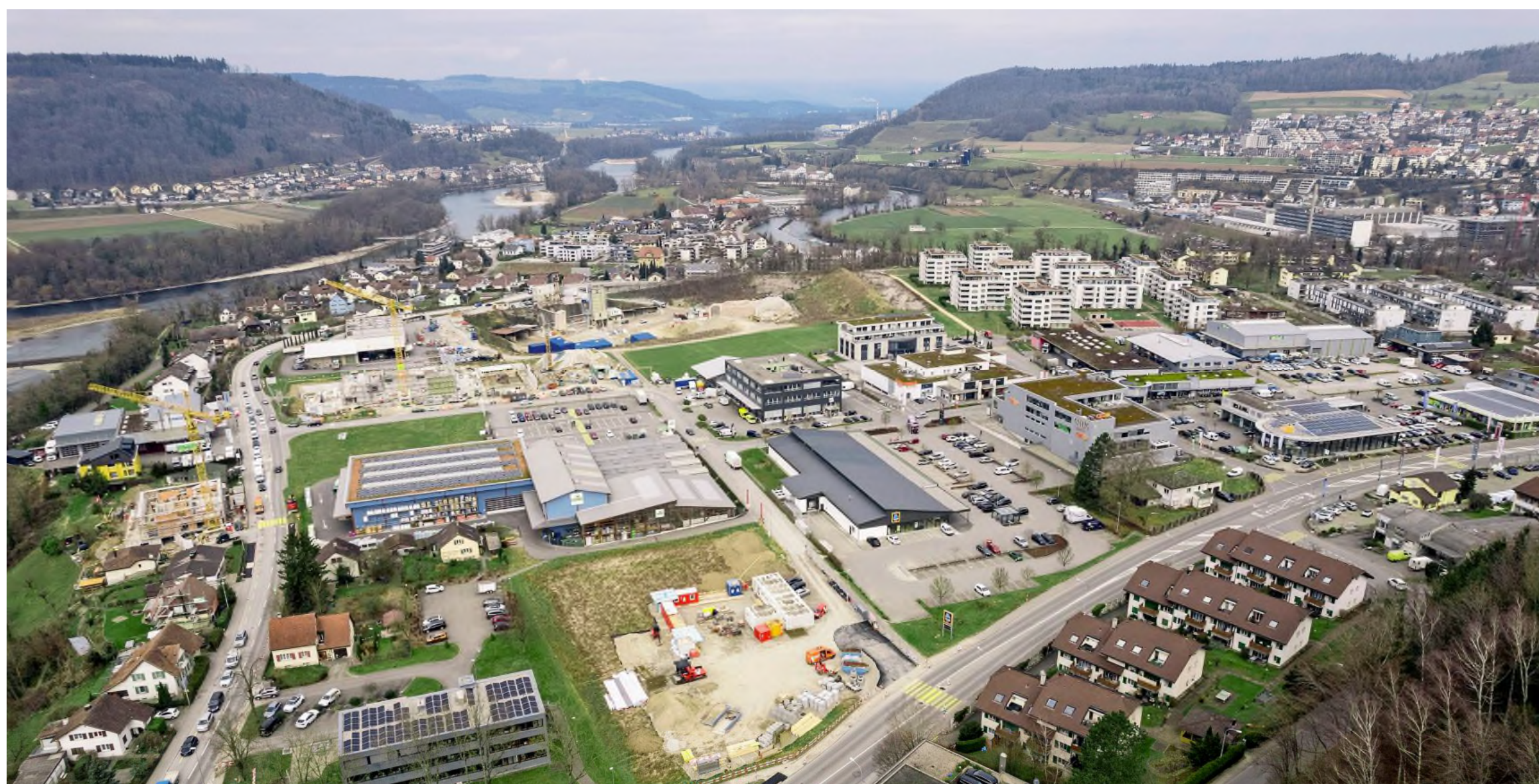
Drohnaufnahme des Gebiets Geelig in Gebenstorf: Neben Aldi, Migros, Coop und Co. soll auch viel Wohnraum entstehen.
